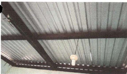
foto 5: Mantenimiento de estructura de madera. Modulo 1
