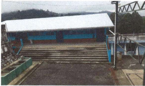
Foto 1 : Sustitucion de lamina por lamina troquelada aluzinc calibre 26. Modulo 3
