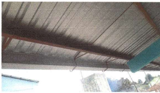
Foto 3: Sustitucion de canal de PVC por metal. Modilo 3.
