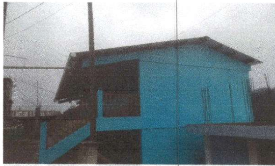
Foto 2 : Sustitucion de lamina por lamina troquelada. Modulo 3
