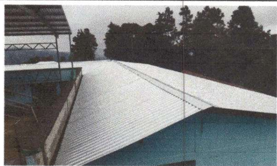
Foto 6: cambio de techo en mal estado, lamina oxidada y quebrada. Modulo 1
