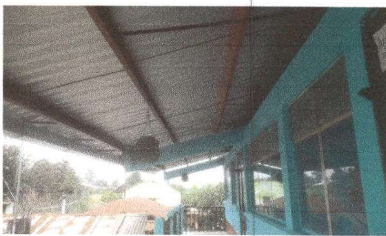
Foto 4: Sustitucion de estructura de soporte de metal pot metal (una parte). Modulo 3
